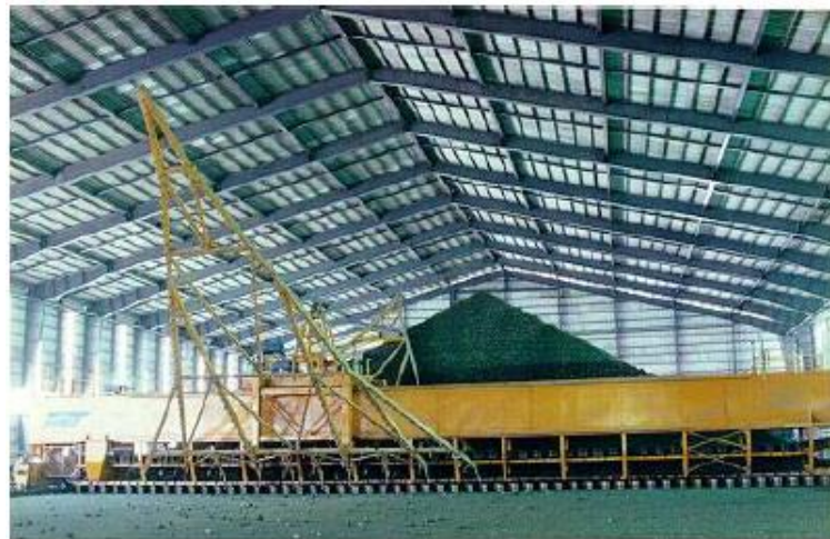
ภาพที่ 2.3 การนำกองวัตถุดิบเข้าเผาสำหรับกระบวนการผลิตปูนซีเมนต์
