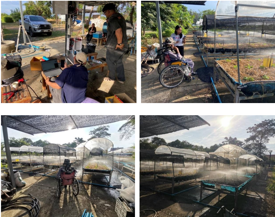
ภาพที่ 4.23 การติดตั้งระบบรดน้ำและระบบควบคุมการรดน้ำอัตโนมัติด้วย IoT ในศูนย์เรียนรู้บ้านตอยาง ต. ช่องสาธิต อ. พัฒนานิคม จ. ลพบุรี เพื่อช่วยคนพิการให้ปฏิบัติงานได้สะดวกขึ้น
