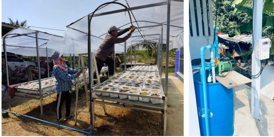
ภาพที่ 4.14 การติดตั้งระบบท่อส่งน้ำสำหรับรดน้ำและระบบควบคุมการรดน้ำอัตโนมัติควบคุมด้วย IoT
