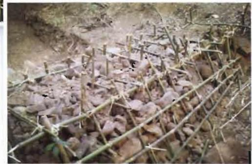
**วิธีที่ ๔** สร้างฝายชะลอกความชุ่มชื้น ที่เรียกว่า Check Dam เพื่อปิดกั้นร่องน้ำหรือลำธารขนาดเล็กเป็นระยะๆ เพื่อใช้เก็บกักน้ำและตะกอนดินไว้บางส่วน โดยน้ำที่เก็บไว้จะซึมเข้าไปสะสมในดิน ทำให้ความชุ่มชื้นแผ่ขยายเข้าไปทั้งสองด้านจนกลายเป็นป่าเปียก
