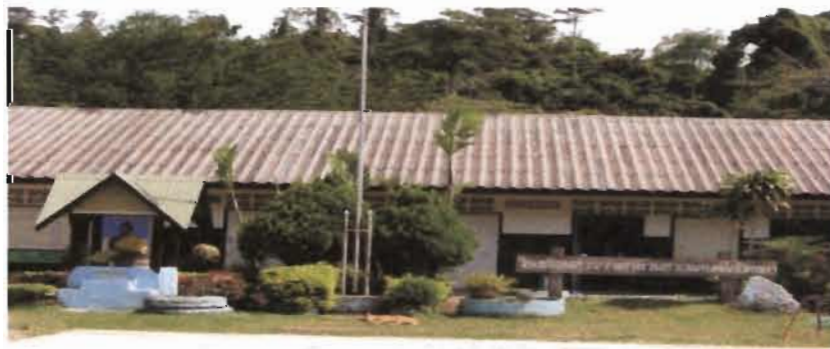
ภาพที่ 27 อาคารเรียนโรงเรียนตำรวจตระเวนชายแดนตะโกปิดทอง
